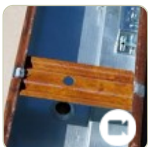
Montaż drzwi zewnętrznych KMT STAL
